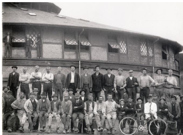
Teglværksarbejdere foran Ringovnen i 1904.
